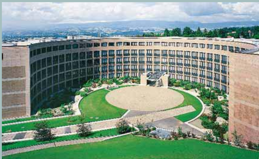
Система распределительных шинпроводов LX находит применение в многоэтажных зданиях, где большое значение придается равномерной передаче больших объемов энергии.
