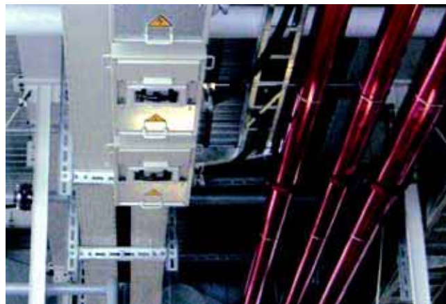
Низкая пожарная нагрузка распределительных шинопроводов
