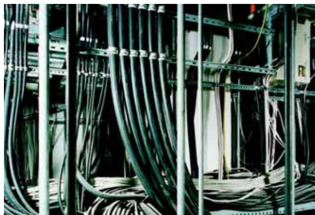
Высокая пожарная нагрузка кабельных разводок
